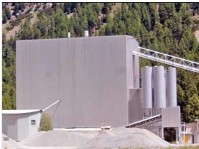
Die in der reizvollen Flusslandschaft von Montebello bei Pontresina im Engadin in den vergangenen Jahren neu erstellten Kies- und Betonanlagen fügen sich gut in die Landschaft ein. Fotos: H.PI.
