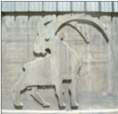
Wahrzeichen des Werks Montebello: Der in SCC-Beton gegossene Steinbock
